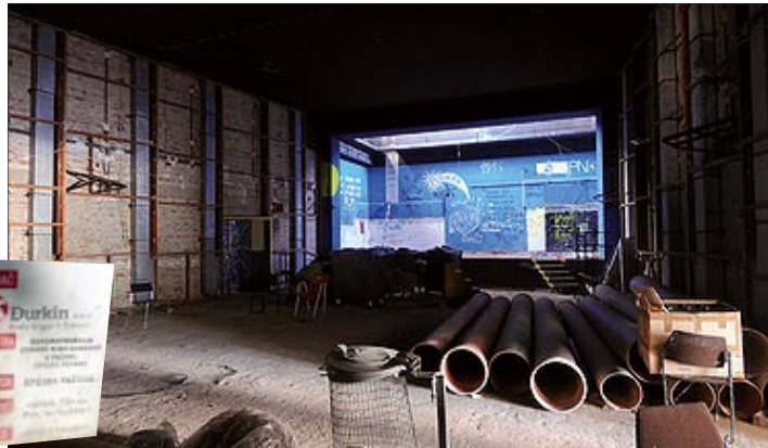
Bivša 'Plompa' postala gradilište
