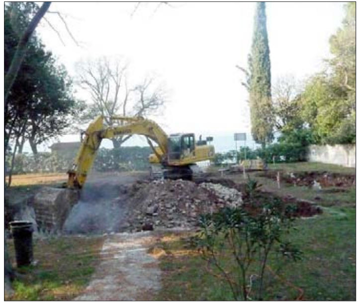
Građevinski radovi u Kampu vatrogasne mladeži
