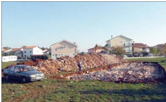
Gradilište upojnog bunara uz Ulicu Dragonja
